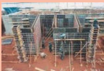
Montagem de formas metálicas das paredes internas, eixos X0 / X1, entre eixos Y8 / Y6. Serviços de concretagem estão sendo realizados, bem como a construção de muros de contenção dos prédios já existentes.
